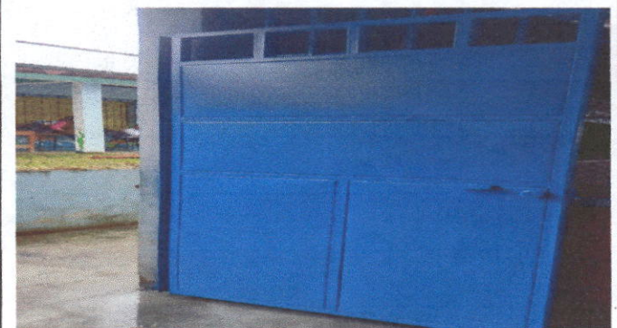
Foto 4: Mantenimiento a puertas de metal.
