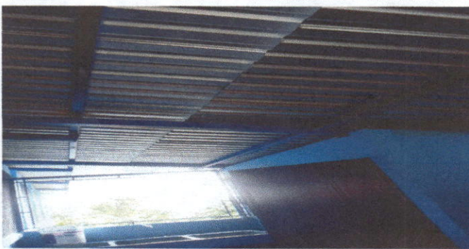
Foto 5: Mantenimiento a estructura de soporte de metal.
