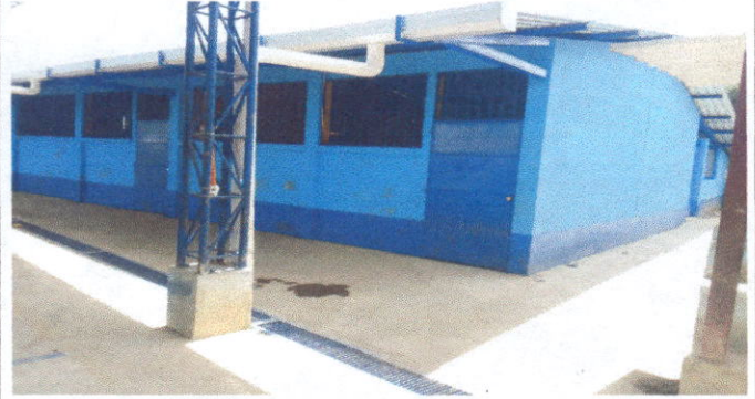
Foto 2: Canales y bajadas de agua.
