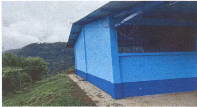
Foto1: Pintura de exteriores.
