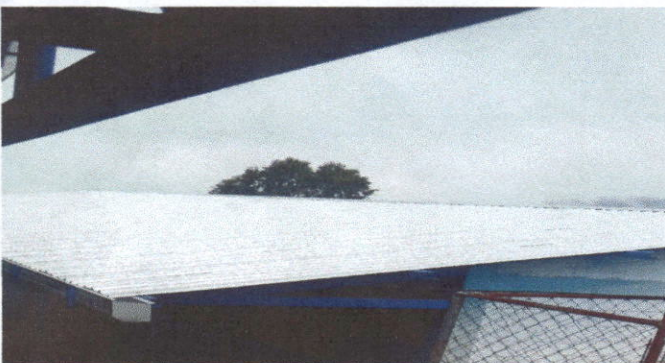
Foto 3: Sustitución de lamina troquelada aluzinc calibre 26
