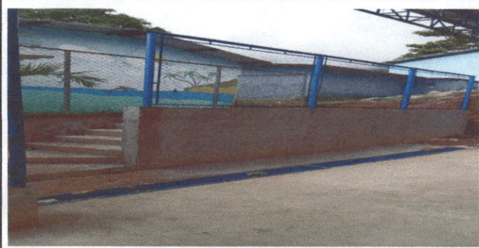
Foto 6: Reparación de muro perimetral.
